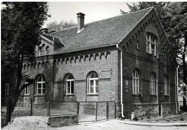
Fot. 6. Przedszkole po remoncie – widok z przodu
